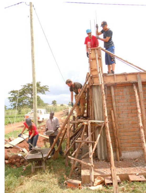
Betonieren des Maschinenhauses
