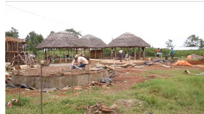
Auf der Baustelle in Iyolwa
