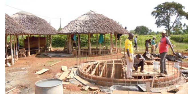
Auf der Baustelle in Iyolwa
