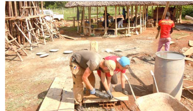
Zuschnitt mit der Tigersäge
